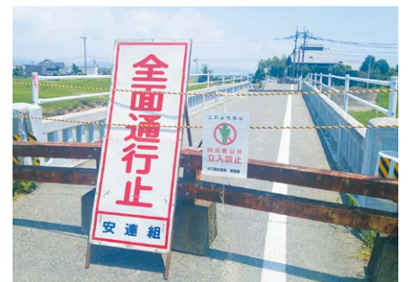
通行止により大きな影響が出ている
