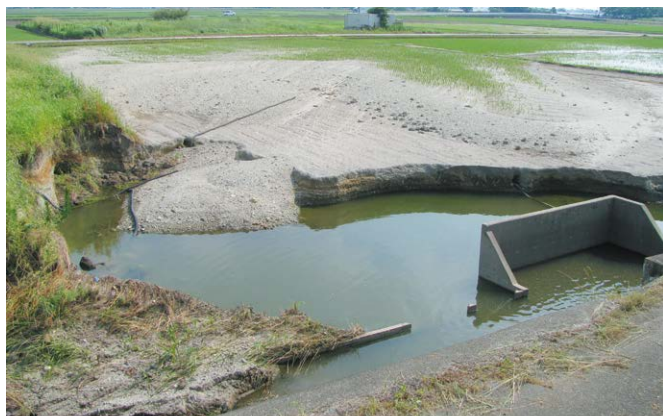
被害を受けた水田（高樋）
