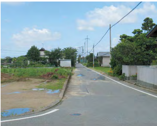
拡幅予定の上下団地東側町道
