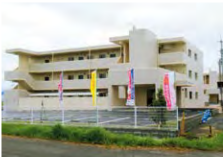
建設中の定住促進住宅（上高橋）
