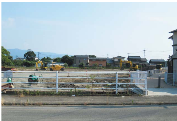
工事が始まった3カ所目の定住促進住宅(富多)
