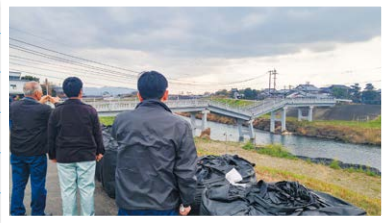
災害箇所の調査(菅野橋)
