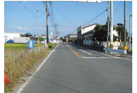
側溝・歩道の整備予定地（上高橋）
