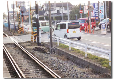
危険な大堰駅踏切交差点
