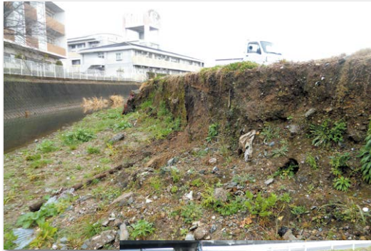
河岸壁がえぐられた 芳原川(山隈)
