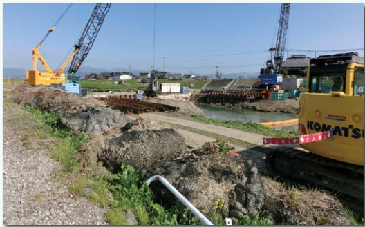
架け替え工事中の菅野橋
