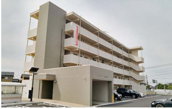
完成した3か所目の地域優良賃貸住宅(大堰駅前)
