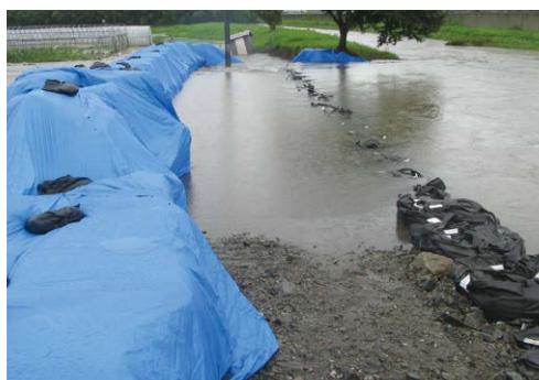
町内各所で災害復旧が進められている
