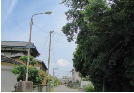
水銀ランプを使用した防犯灯
