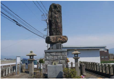
倒壊しそうで危ない碑も多い
