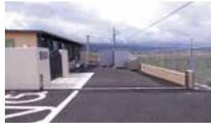
大堰保育園に止水壁を設置
