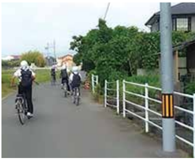
通学路にも危険な空き家がある
