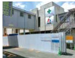
改修が始まった中央公民館
