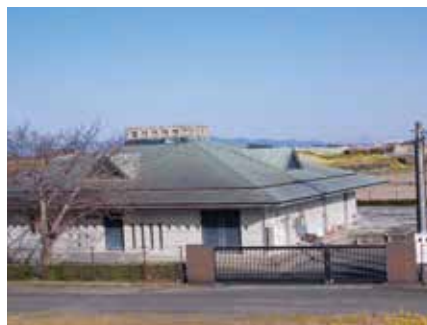
大堰地区の下水を処理する（西原）
