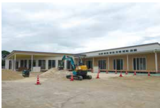
建設中の新保育園（北鶴木）
