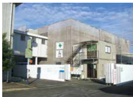
改修中の避難所（中央公民館）
