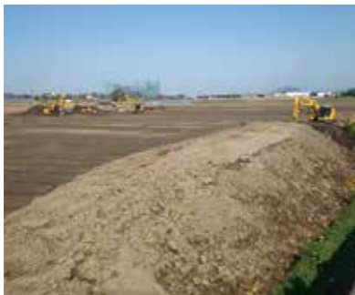
進行中の調節池工事（高樋）
