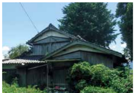
不良家屋の解体補助も行っている
