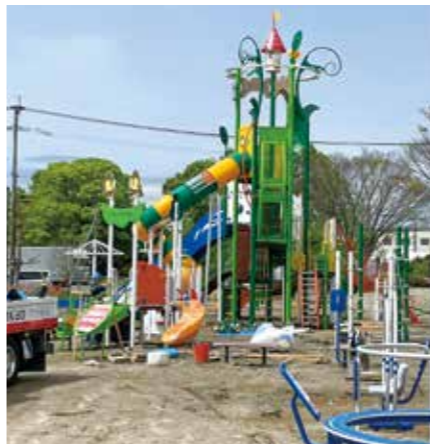
完成間近の遊具(運動公園)
