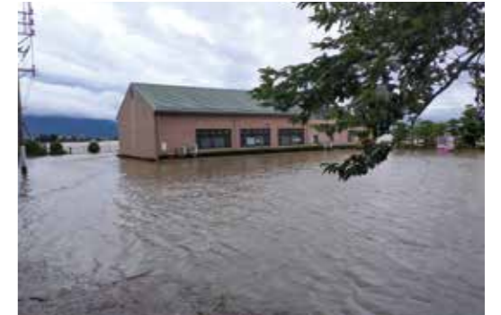
床上まで浸水した大堰交流センター(令和2年)
