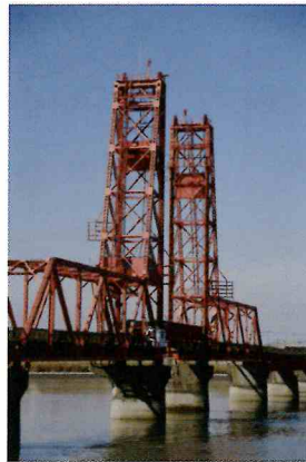
▲筑後川昇開橋
