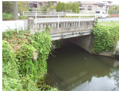
大刀洗川橋（1919年架設）
