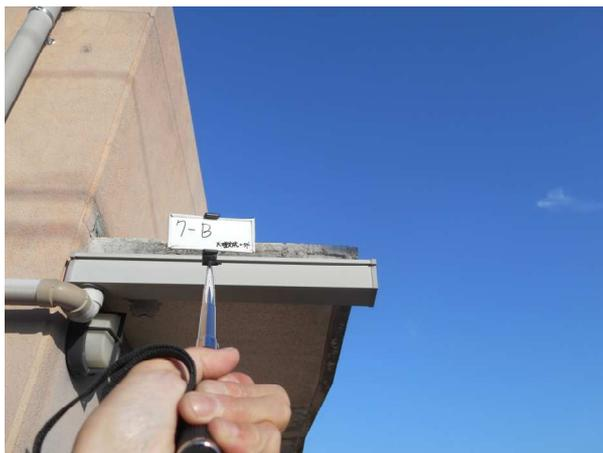
大堰交流センター【南西側】庇側面の露筋
