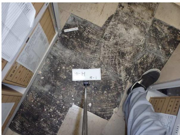
大刀洗庁舎 庁舎【1階西側倉庫】床材の剥がれ
