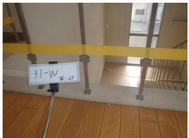
武道場【2階階段室】手摺アクリル板の破損
