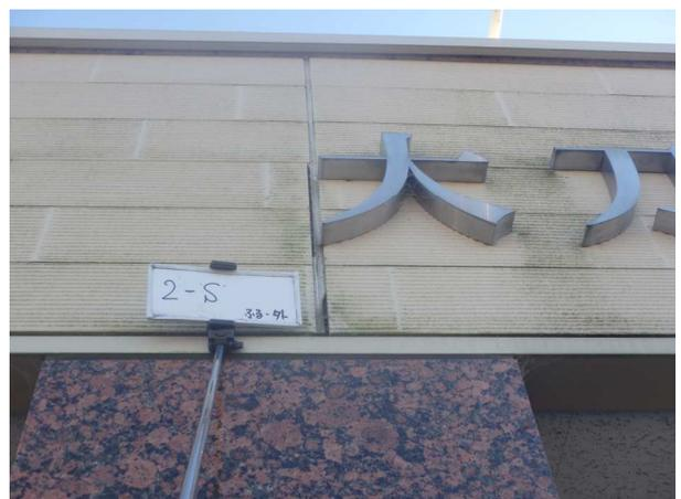
大刀洗斎場ふるさと【北側】外壁シーリングの著しい劣化
