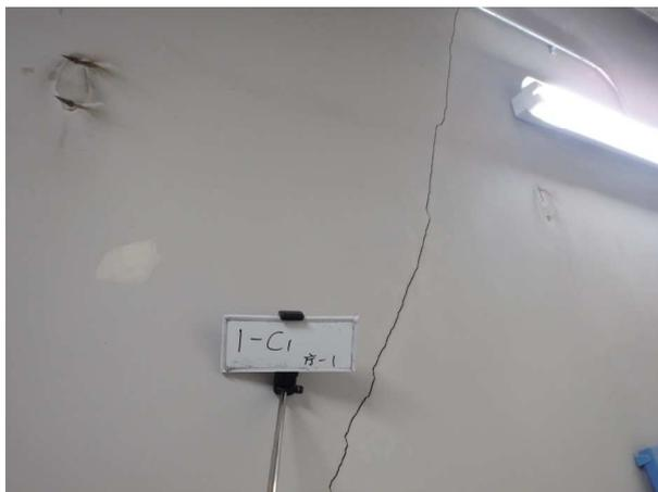
大刀洗庁舎 庁舎【1階機械室】壁のクラック幅 1.0 mm以上
