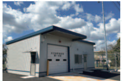
⑦消防第1・第4分団車庫更新
